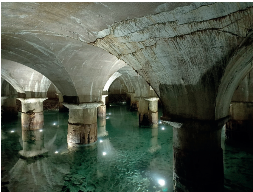
Bassin filtrant de l'ancienne usine des eaux de Saint-Clair ©Caroline Januel
