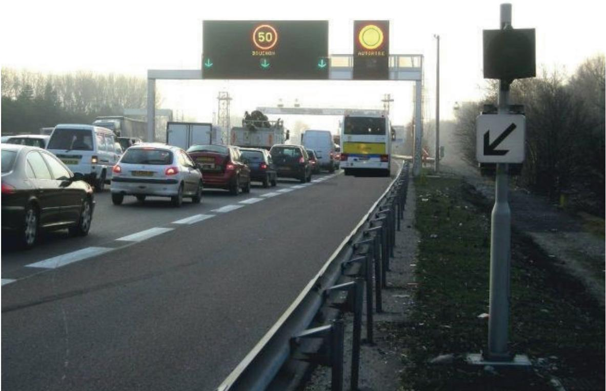
Figure 6 : La « voie spécialisée partagée » sur l'A48 en direction de Grenoble, [https://www.rse-egis.fr/solution\\_egis/la-gestion-dynamique-des-voies-gdv/](https://www.rse-egis.fr/solution_egis/la-gestion-dynamique-des-voies-gdv/)
