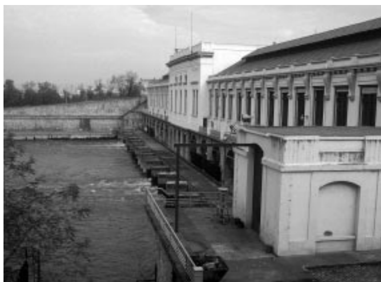
Cusset - l'usine hydroélectrique
