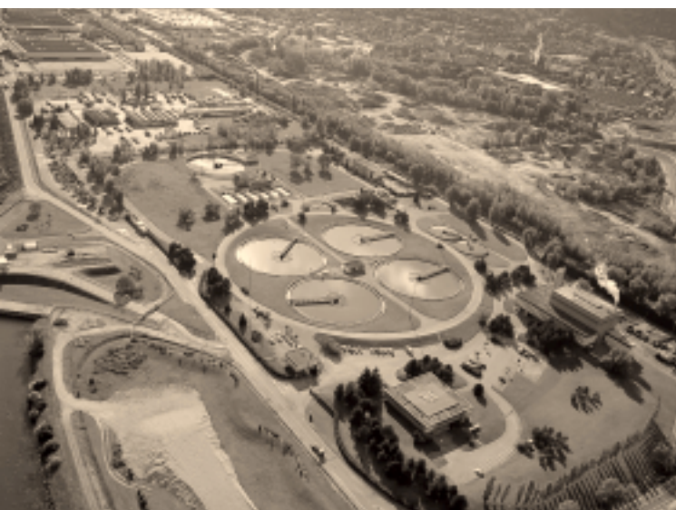
Station d'épuration de Pierre-Bénite
