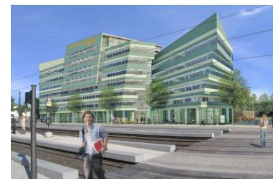
Le pôle de la coopération et de la finance éthique, en construction. Source : http://www.etamine.coop/
