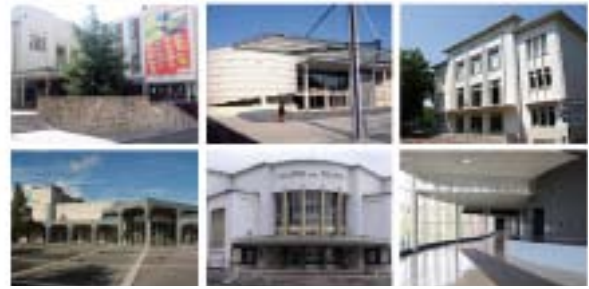
Différents équipements culturels construits dans les villes de la périphérie de Lyon
