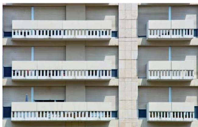
Détails de façades. De haut en bas : - ensemble Moncey Nord - résidence du Lac - résidence Desaix
